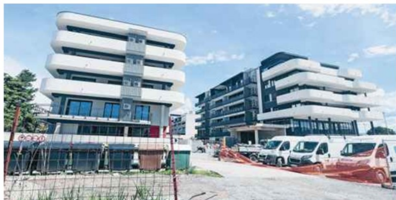
Ob Ferrarski cesti gre h koncu gradnja soseske Ewol Senior 55+, namenjene zgolj starejšim.
